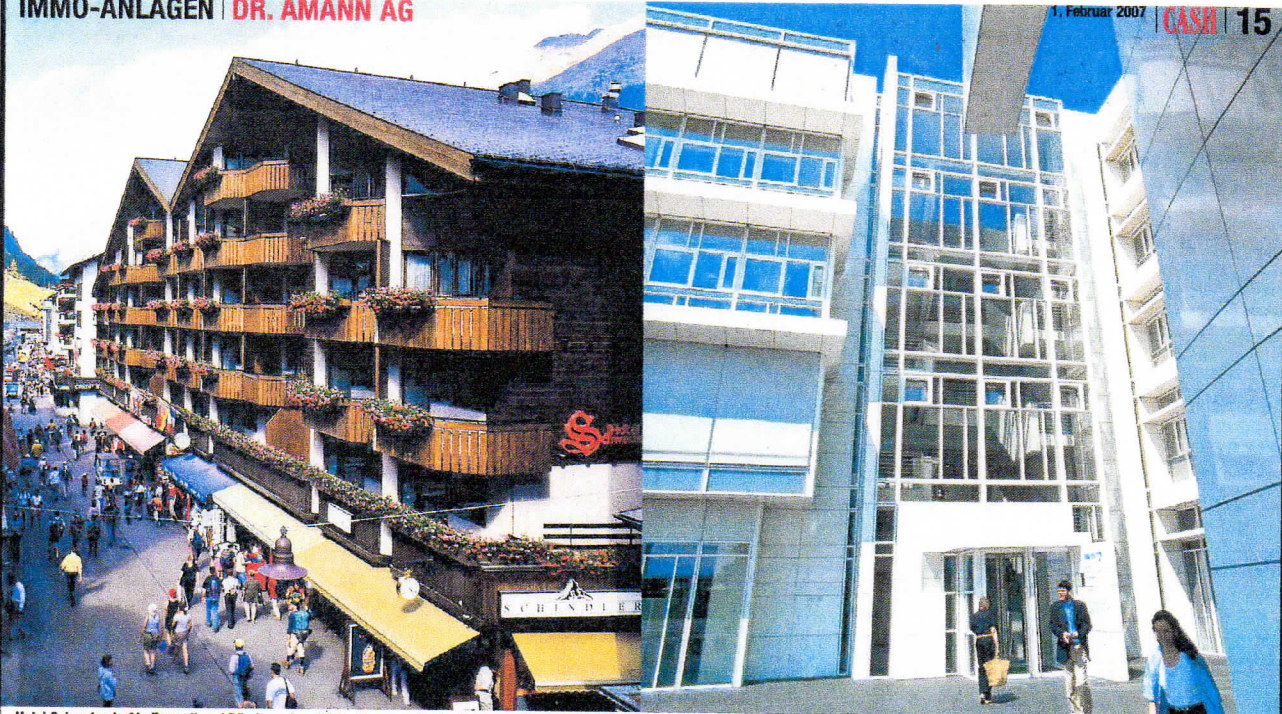
Hotel Schweizerhof in Zermatt und Bürokomplex «White Plaza» an Basler Bestlage: Einstige Vorzeigeprojekte von Kommanditgesellschaften des Zuger Immobilienhändlers Jürgen Amann.
